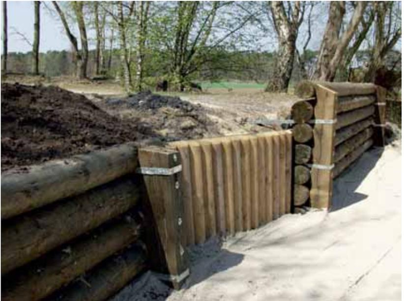
*Aufbau eines Wassereinsprungs*
